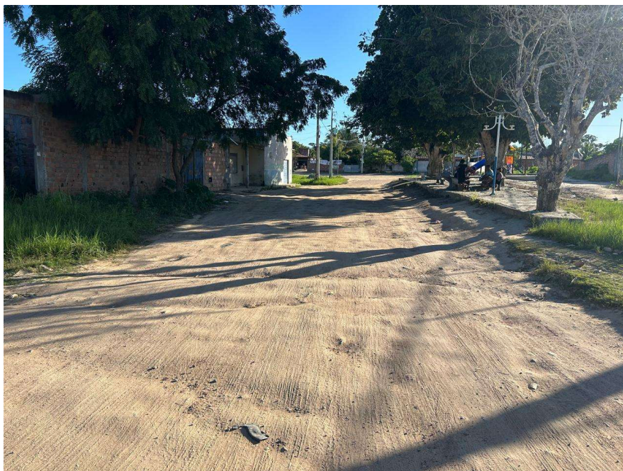
RUA A- TRECHO 2
